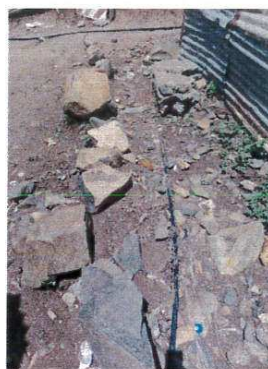
Photo n°16 : tuyau d'eau d'origine inconnue
