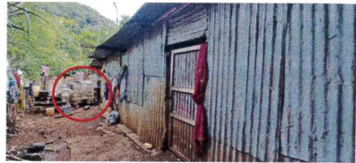
Photo n°20 : citerne de récupération des eaux pluviales
