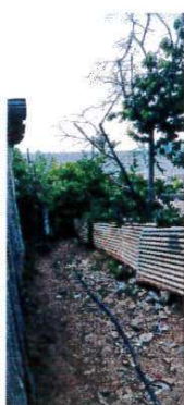
Photo n°17 : tuyau d'eau d'origine inconnue
