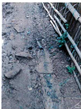
Photo n°25 : tuyau d'évacuation d'eaux usées
