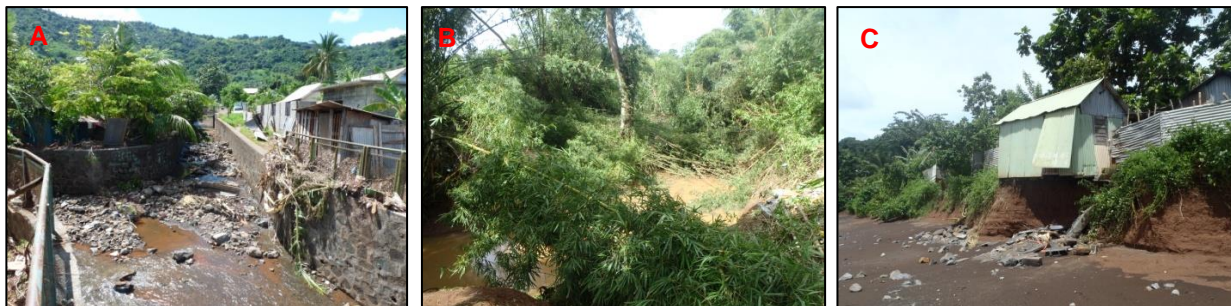
Figure 11 – Impacts du cyclone Hellen, mars 2014. A : Laises de crues sur le garde-corps du canal dans le centre-ville d'Acoua ; B : Embacles formés par les bambous dans le lit de la rivière en amont du pont de Dzoumogné ; C : Affouillement sous une habitation en tôle (village de Nyambo- Bandraboua).
