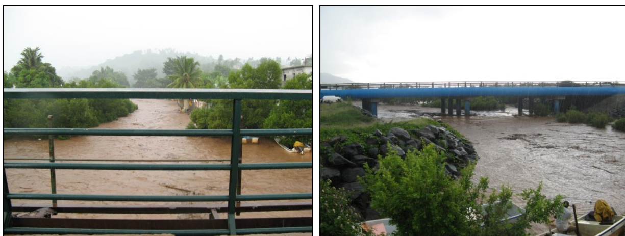
Figure 12 – Crue de la rivière Gouloué.
