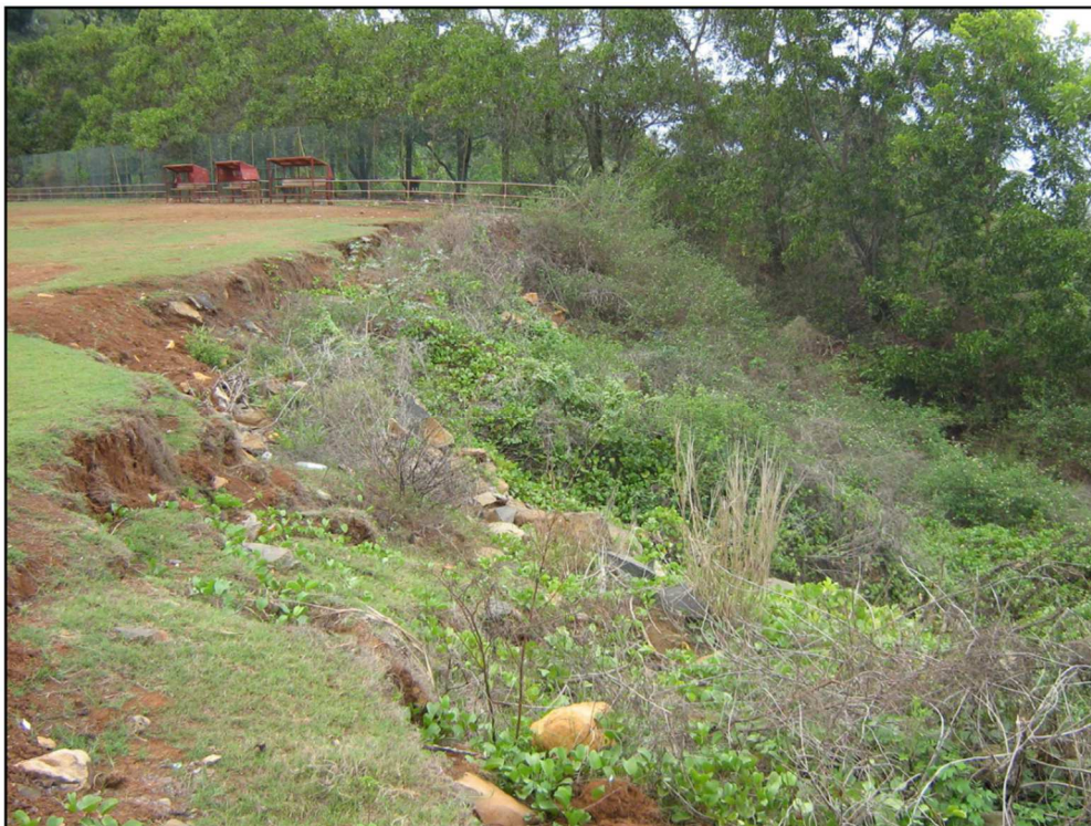
Illustration 5 – Glissement de Novembre 2004 (Source : SEGC MAYOTTE)
