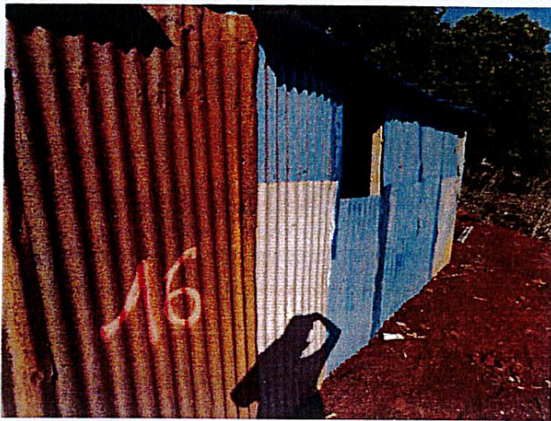
Photo 17 : local en tôle en construction.
