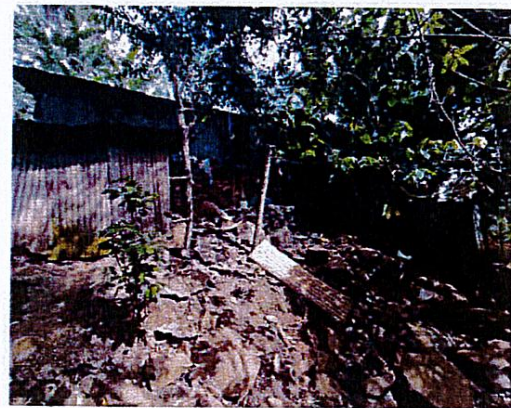
Photo n°20 : logements instables battis sur une pente ;écoulement d'eaux usées en milieu superficiel, risques chute et blessures, Risque inondation par débordement du cours d'eau.
