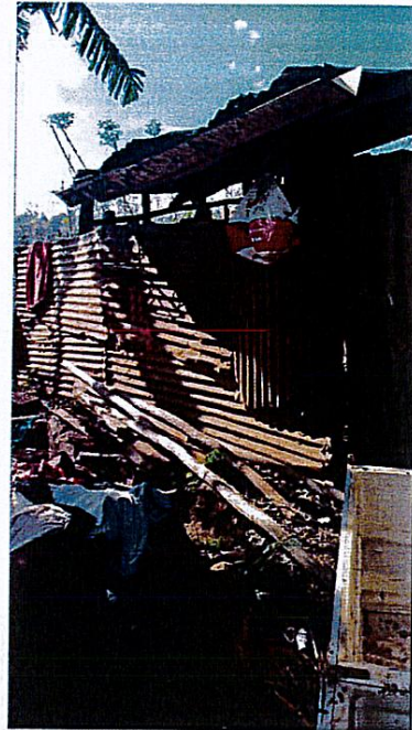
Photo n°26 : installation sommaire de récupération d'eau pluviale.
