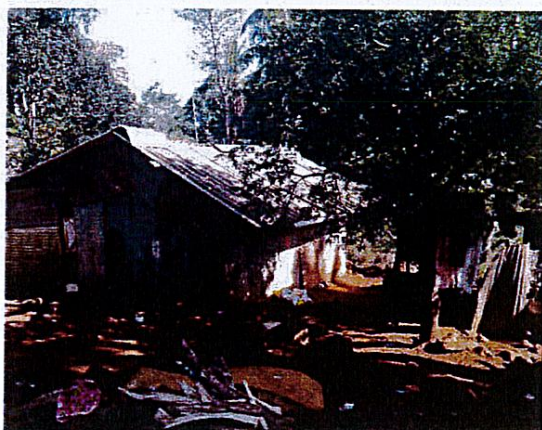
Photo n°11 : constructions précaires sur terre battue.
