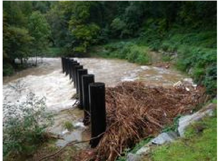
Exemple de piège à embâcle sur la Deûme en aval d'Annonay (Source : Syndicat des trois rivières)
