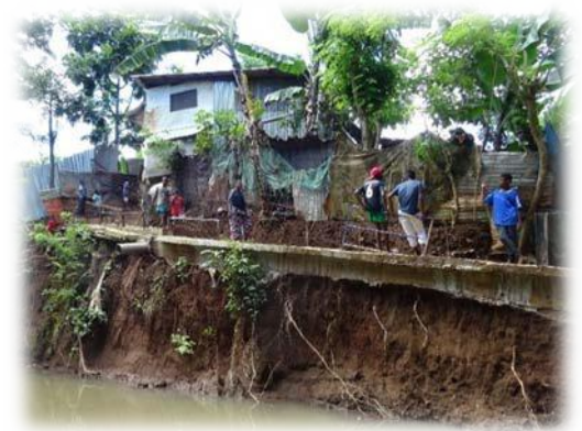
Exemple de cheminement piéton le long de la rivière Gouloué (quartier de Passamaity)
