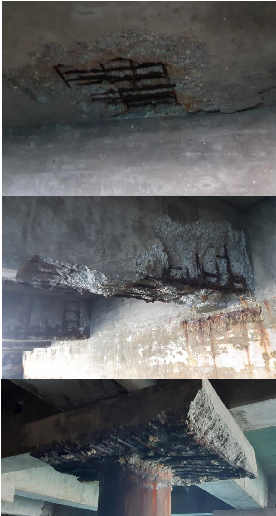
Figure 5: Photographies des poutres et dés en sous-face du Quai 1 (inspection visuelle SAFEGE – Août 2020)
