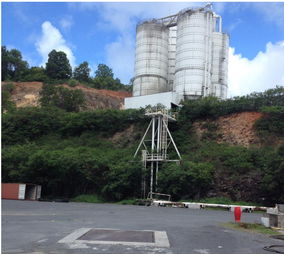
Figure 19: Chambre de raccordement dans le terre-plein vers la cimenterie
