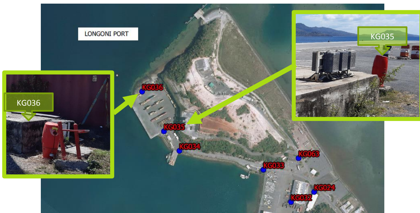
Figure 10 : Localisation des poteaux incendies (source : SDIS)
