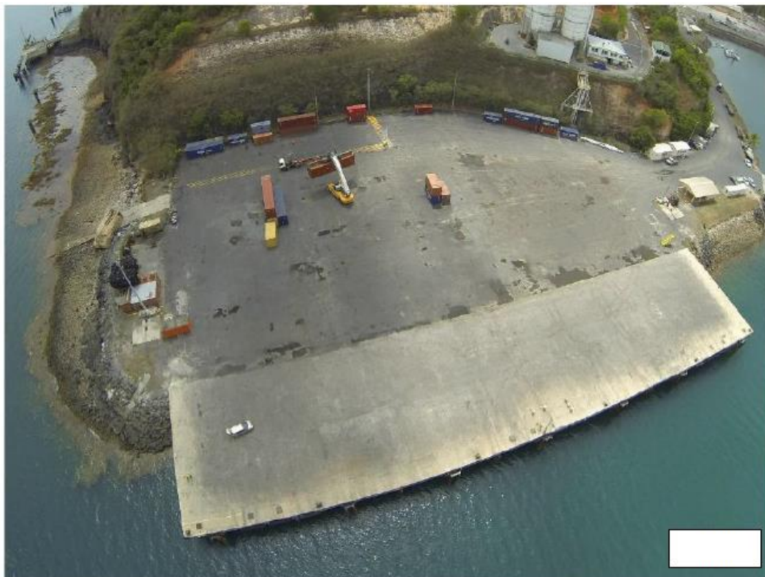
Figure 3 : Vue vers l'Est sur le quai n°1 (Source : Artelia, 2019)
