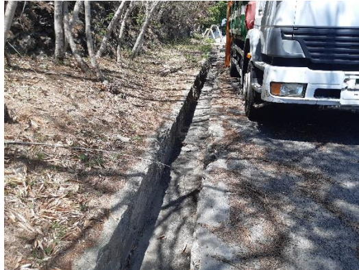
Figure 11 : Caniveau de collecte longitudinal (route d'accès au quai)
