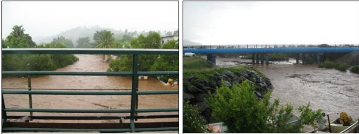
Figure 18 : Crue de la rivière Gouloué
