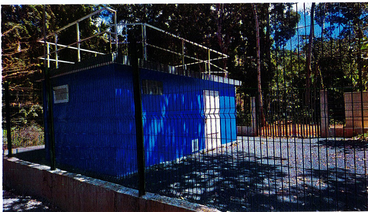
FIGURE 4 : PRISES DU VUE DU FORAGE DE MAJIMBINI (EGIS EAU, 2018)
