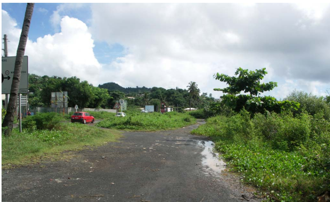
Ancienne piste de chantier de la rocade de la RN2
